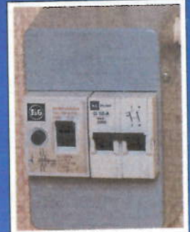
Aardlekschakelaar en zekeringautomat. Extra veiligheid.
